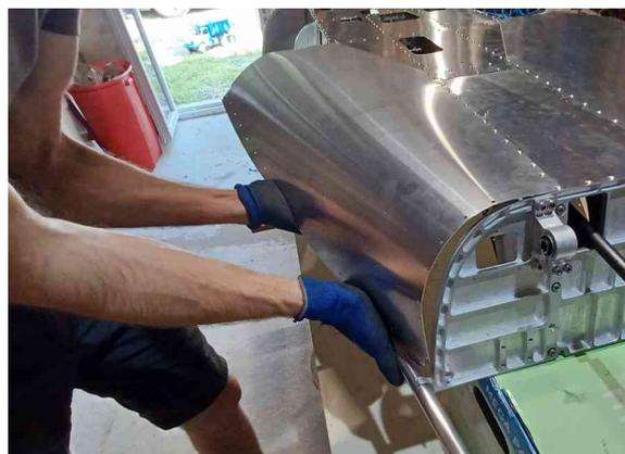
Avant de continuer le rivetage sur les côtés, faites doucement passer la tôle dessous le tube puis terminez le rivetage.
