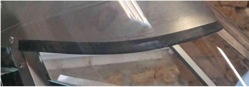
Posez le joint en caoutchouc J2 sur l'avant de la casquette, selon les assemblages, le coller peut être nécessaire.
